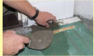
Opvullen putje met cementmortel
