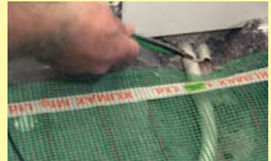
Doorvoeren draad
