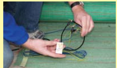
Klikspaan aansluiten tijdens het tegelen
