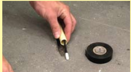
Installatie vloervoeler
