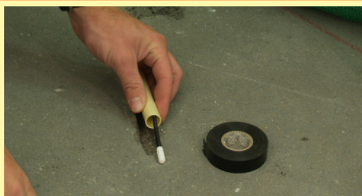
Installatie vloervoeler
