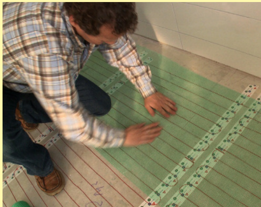
Wrijf het geheel goed strak op de vloer
