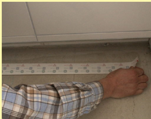
Kleef de afstandstape op de vloer
