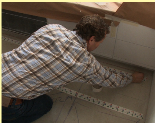
Werk bij voorkeur vanaf het verste punt terug naar de trekveer
