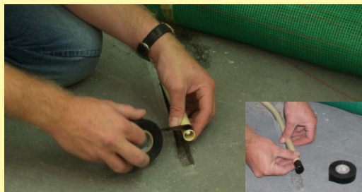
Duw de voelerdraad vervolgens aan het einde terug en tape of dop deze zorgvuldig af.
