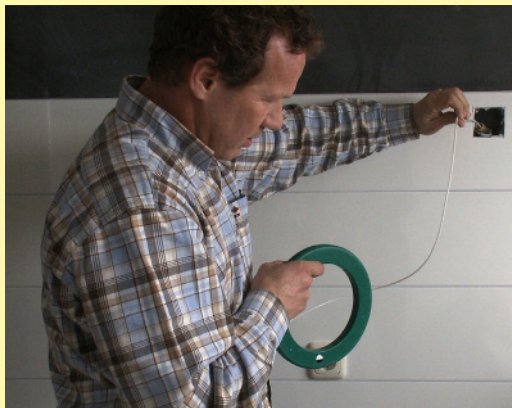
Invoeren van trekveer in invoerbuis
