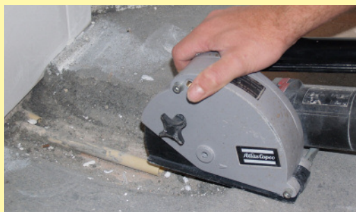
Sleuf maken vloervoeler
