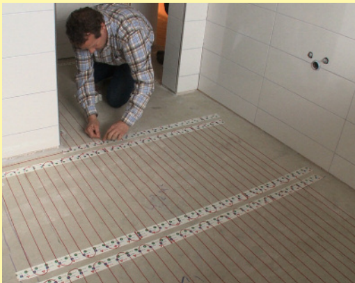
Werk de draad in zijn geheel op
